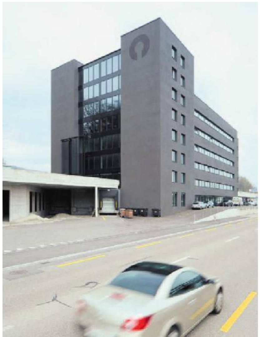
Vom Gartenrestaurant in die Dach-Disco: Ein Lift verbindet die Lokale, die Royal Döner in der Steigmühle eröffnen will. Bild: Peter Würmlin
